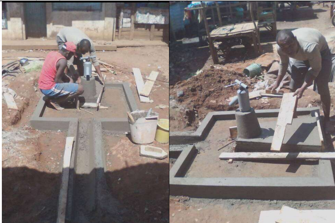
Photo 03 : Lors de la finition de la dalle d'assainissement (deux jours après le coulage des bétons)
