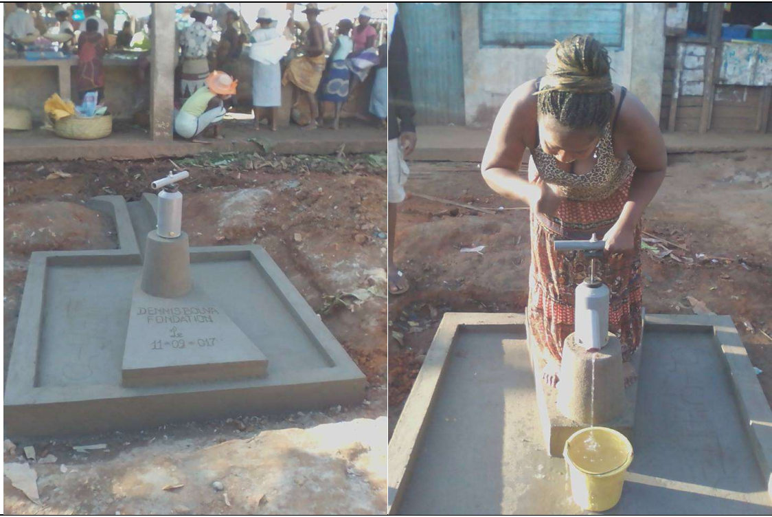
Photo 04 : Forage équipé de la pompe Canzee au marché de Marofarihy
